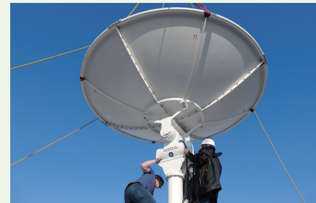
3.8m口径のパラボラアンテナの据付
