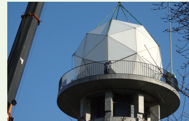
アンテナ設備を保護するレドームを取付
