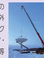
パラボラアンテナ施工状況
